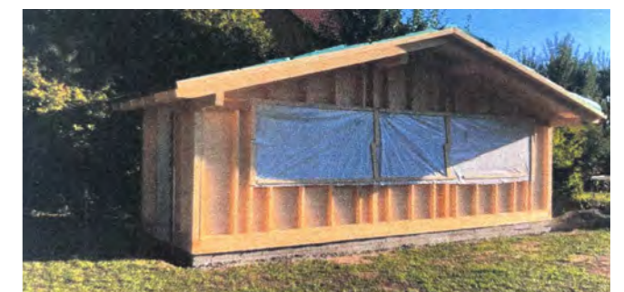
◆ Die neue Mehrzweck-Grillhütte ist fast fertig. (Fotos: Ralf Pöstov und Manuela Pfeifer)
