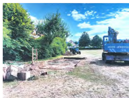
◆ Der Bau der Grillhütte kann beginnen.
